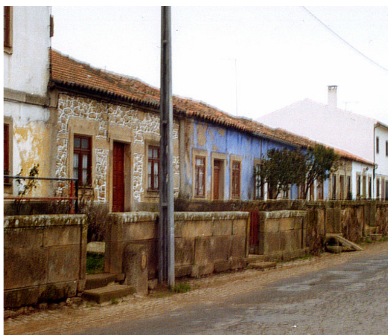
FOTO 10 – conjunto de edifícios de arquitectura popular, situado no Bairro do Rodelo
