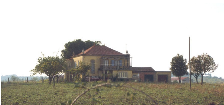
FOTO 2- Edifício residencial de 2 pisos inserido numa propriedade agrícola no interior do perímetro urbano de Figueira de Castelo Rodrigo.
